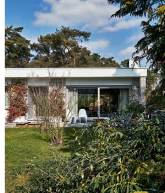
Het aluminium schrijnwerk werd vervangen door hout. Aan de buitenkant is het vergrijsd om mooi te blenden met de gevel in gewassen betontegels.
