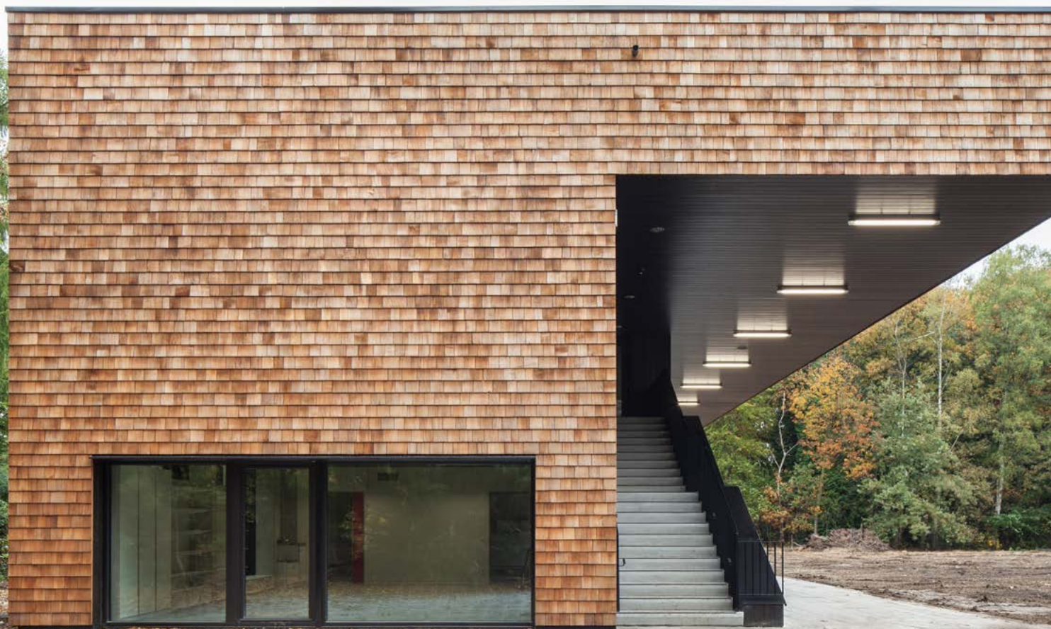
De kleuterschool van de vrije basisschool Zonnekind in Kalmthout telt twee niveaus en zet sterk in op compactheid, isolatie, maximale zonnewinst en zonnewering. (© Ilse Liekens)
