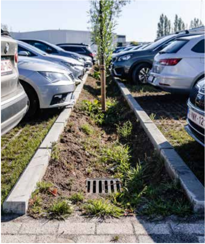
Het tweede kantoorgebouw is gesloopt en vervangen door een waterdoorlatende parking.
