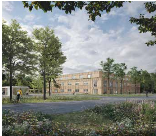
De uitbreiding gebeurde in houtskelet en met CLT.
