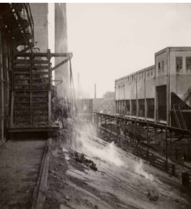
Retortenovens, het lossen van de cokes in 1937 [© Archief Gent]
