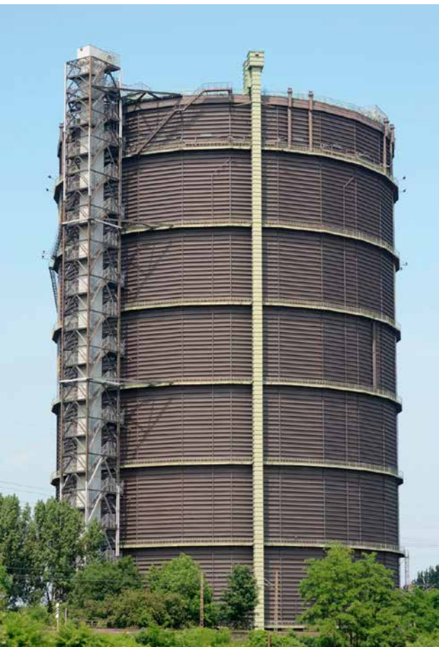
Gazometer Oberhausen – Dry seal (foto Thomas Machoczek, Wikimedia Commons)
