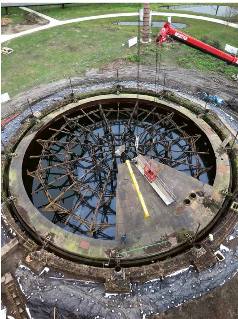
Demontage bovenstructuur en dakklok tijdens de restauratiewerken in 2020 (foto Denys)
