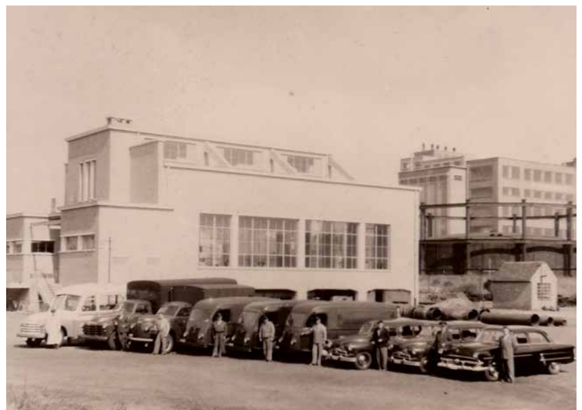
Compressorenzaal van Georges Bontinck uit de jaren 50 met rechts een gashouder [© Archief Gent]
