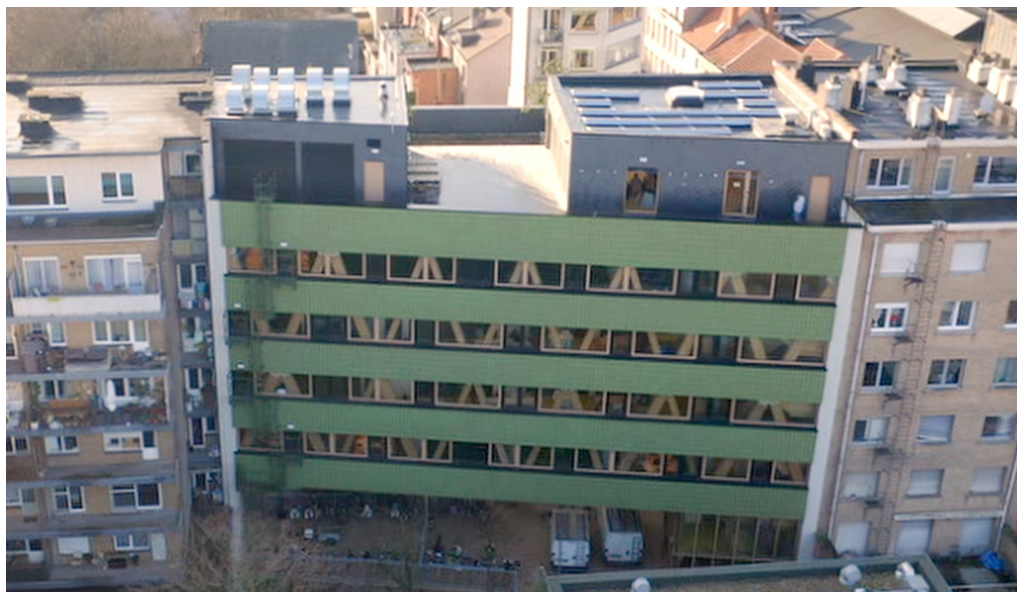
Mundo-a, een bio-ecologisch passief kantoorgebouw te Borgerhout, in opdracht van Ethical Property.
