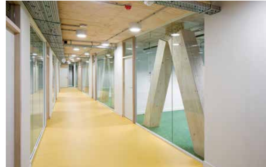
Binnenin is de houten structuur maximaal zichtbaar gebleven.
