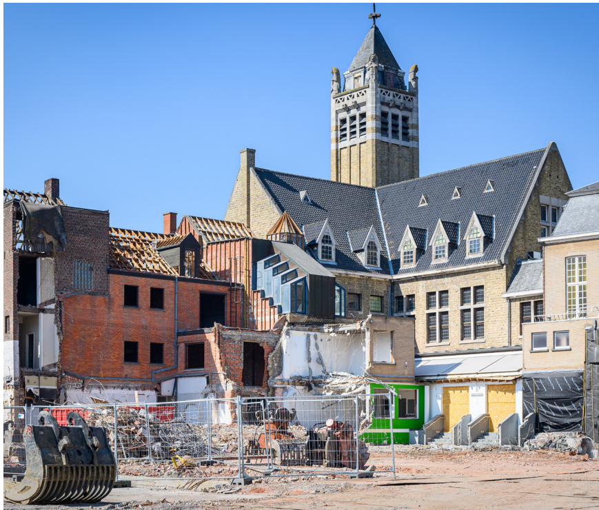
Afbraak Zuidstraat © Departement communicatie, stad Roeselare
